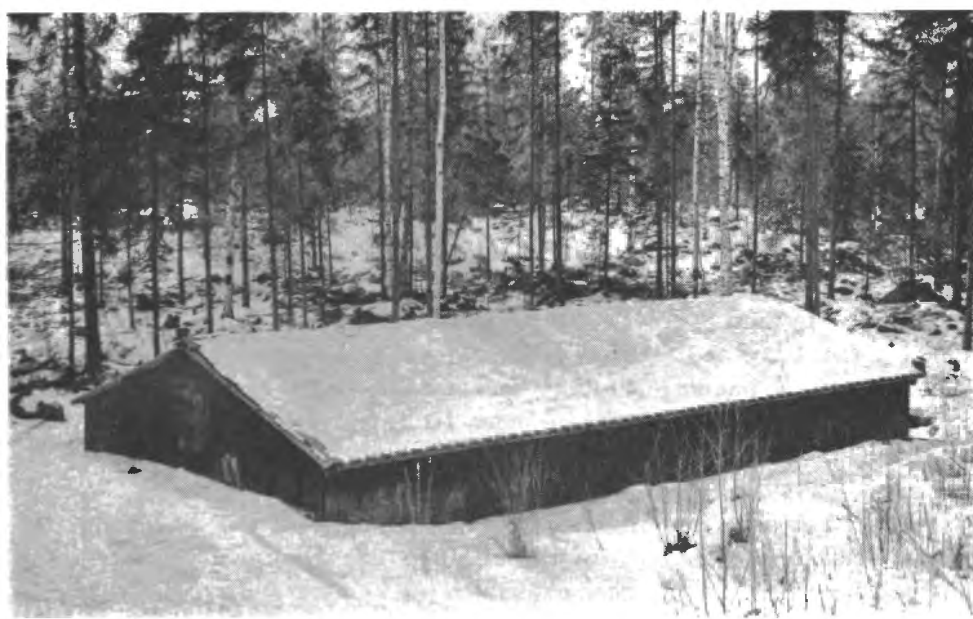
Fig. 13. Öppen branddamm med en köldisolerande överbyggnad av trä.
