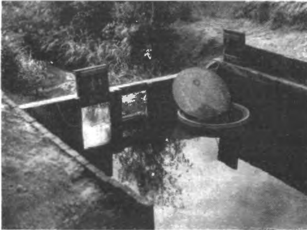
Fig. 10. En damm i bäck med sugsilskar av betongrör.
