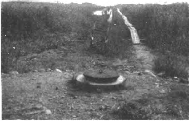
Fig. 4. Från den 200 meter avlägsna sjön ledes vatten genom en intagsränna till uppställningsplatsen.
