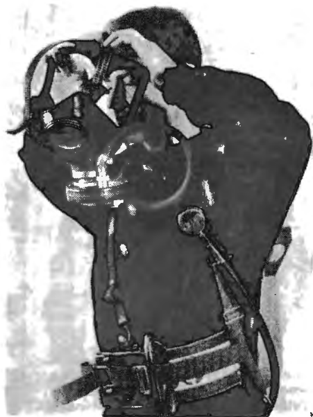
Bild 11. Ansiktsmasken tas på. Behållarventilen skall dessförinnan ha öppnats.
