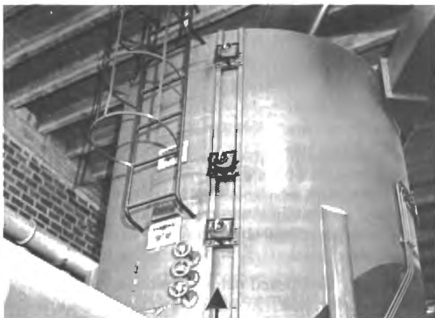
Figur 6 a. Cistern med tre nivåvakter
