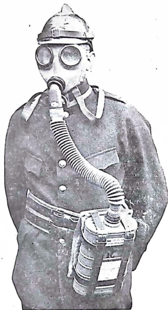
Bild 7. DEGEA-(CO)-koloxidutrustning: Mask, mellanslang, CO-filterburk, bärplatta. Från Stockholms brandkår.
