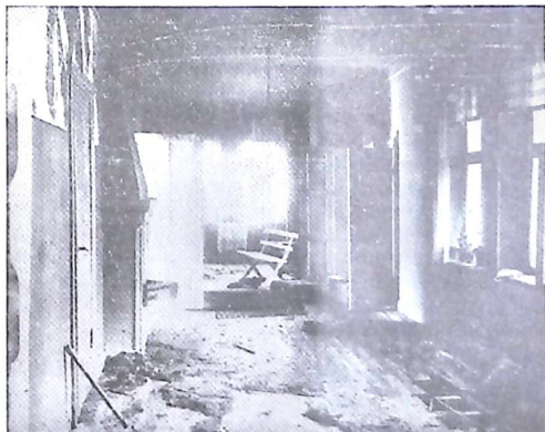
Fig. 7. Övre korridoren efter branden.
