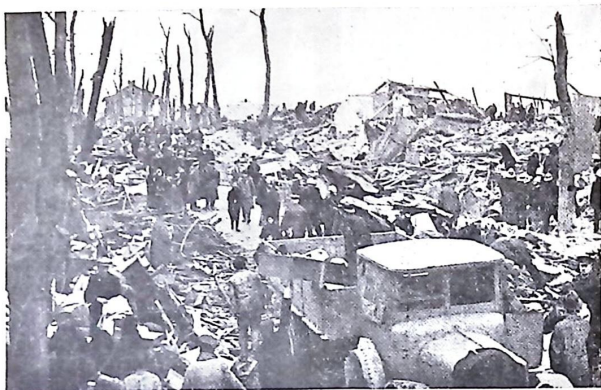
Bild 5. Saarbrückerstrasse mitt för olycksplatsen. De helt demolerade byggnaderna till höger.
