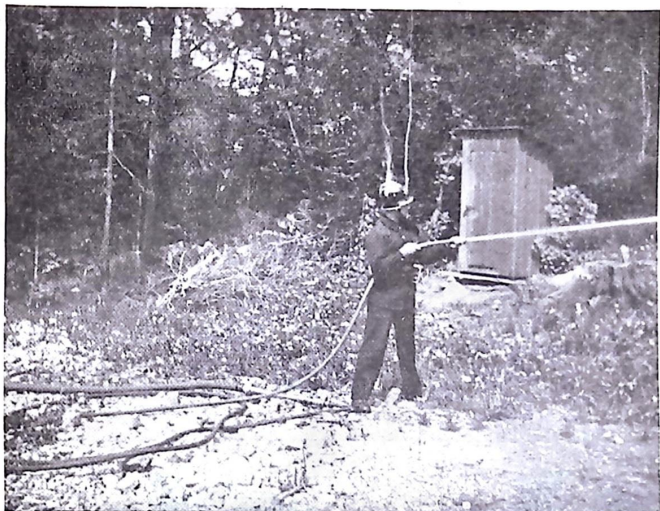
Fig. 3. Lilla munstycket. Sluten stråle. Vid strålförarens fot ligger det stora munstycket med den smala slangen ansluten.
