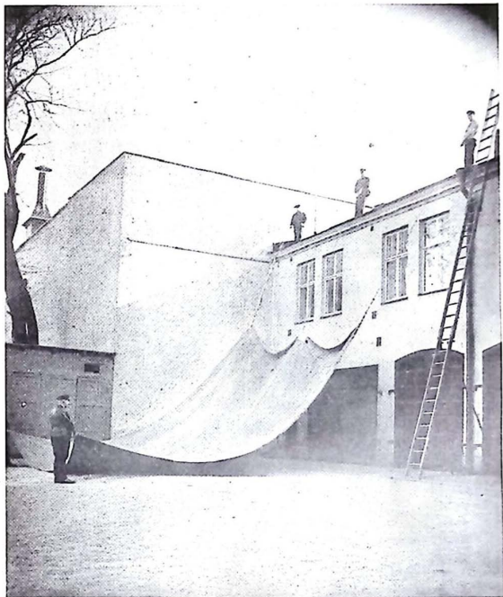
Bild 5. Upphalning av brandsegel av Norrköpingsmodell.
