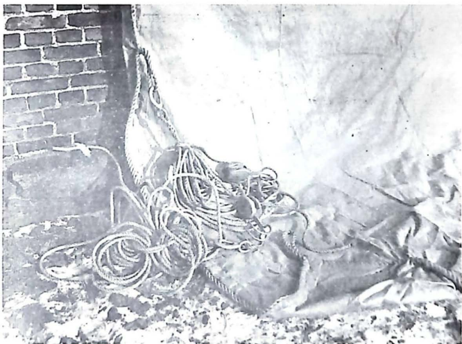
Bild 2. Brandseglets kantskoning och öglor.
