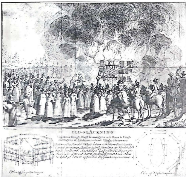
Utseende före påtändningen.
