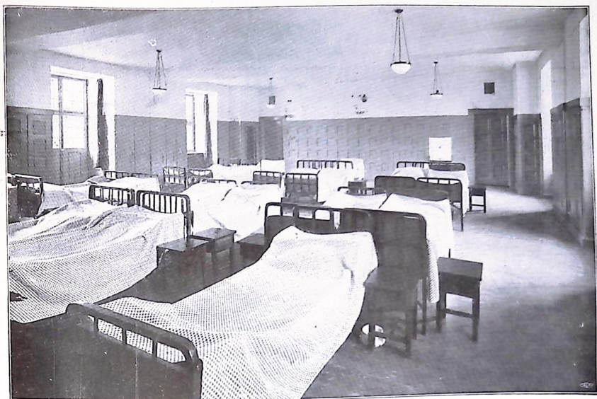
Liljeholmens brandstation. Logementet.
