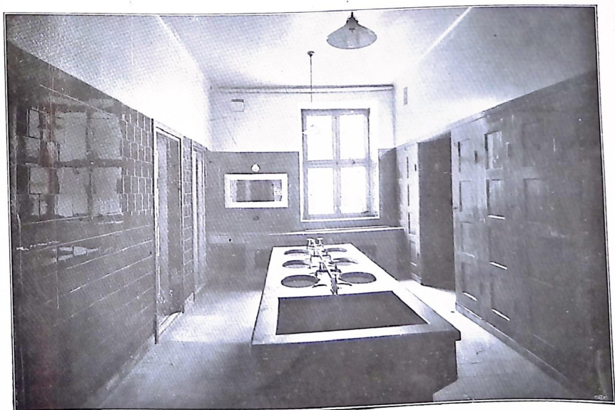
Liljeholmens brandstation. Tvättrummet.
