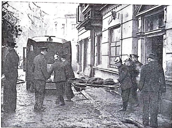
Fig. 8. En av de innebrända bäres ut genom huvudingången. De fyra som hoppade torde hava fallit ned där ambulansbilen står.
