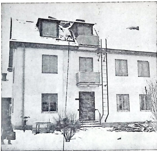
Bild 2. Pilen anger eldstället. Obs den ärmerade balkongplåtens förbindelse med takets fotplåt.
