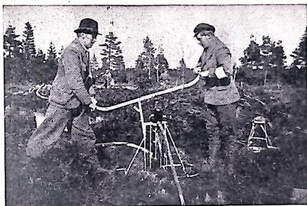
Fig. 7. Blockpumpverk i användning. Ryggmesen t. h. användes för pumpverkets transport.
