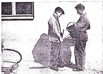
Bild 12. Om vattenledning saknas kan fyllning göras genom tratt, vilket dock blir väl tidsödande.
