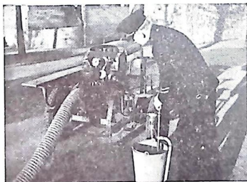
Bild 3. Täthetsprovning. Provpumpens slang kopplad på ett tryckuttag.
