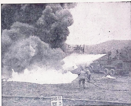
Fig. 3. Amerikansk flyghaverivagn ("Crash truck") under släckning av brinnande bensinyta. Vattendimman från kanonen skyddar brandmännen, som angripa med tre 1" slangar med dimmunstycken
