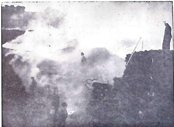
Branden i Staffanstorp andra dagen. T. v. ett av schakten under utgrävning.
