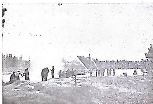
Motorsprutor och blockpumpverk i arbete.
