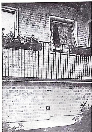
Fig. 3. Brandmursmärke vid sockeln av byggnad.
