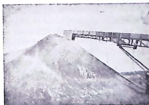
Stacking av frästörv.
