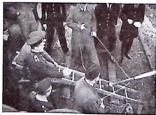
Bild 1. Grovt strålrör monterat på skarvstege enligt amerikansk metod. Anordningen visade sig ej lämplig vid högt tryck.
