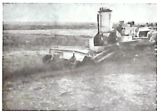
Fräsmaskin med vedgasaggregat i arbete.
