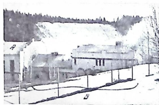
Här synes ställverket vid x. A = nya kraftstationsbyggnaden. B = gamla kraftstationsbyggnaden.
