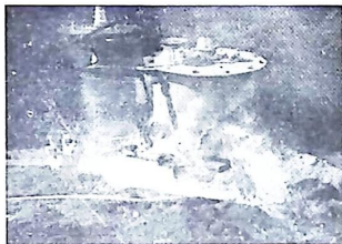
1. Brand i särskilt iordningställd "oljeströmbrytare". Ljusbågen har skurit sönder kärlet och olja brinner såväl i kärlet som på marken.
