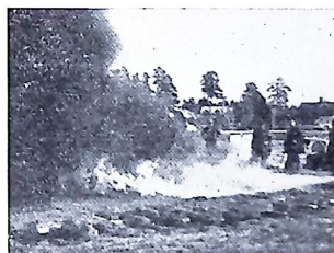
4. Släckning med pulver av oljebrand på jämn, plan yta.
