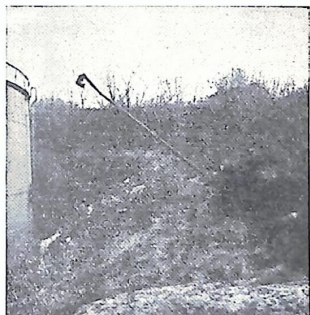
Bild 5. Masten rest men ej utskjuten, vilket sker när vattnet påsläppes. Obs! inriktningen så att huvudet når över cisternens mantel.
