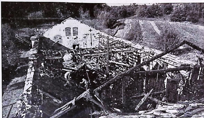
Bild 1. Tagen i vinkeln mellan A och B. Visar verkstad A efter eldsvådan. Observera i förgrunden den brädvägg, muren. Explosionen inträffade vid +.
