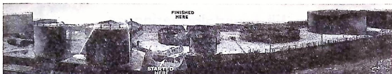
Efter branden. — Raserade tankar och ett hav av skum. Branden började i den lilla tanken i främre delen av bildens mitt. Bortom är den stora tanken, som envist motstod brandmännens släckningsförsök. (Bilden hämtad ur Fire Protection.)
