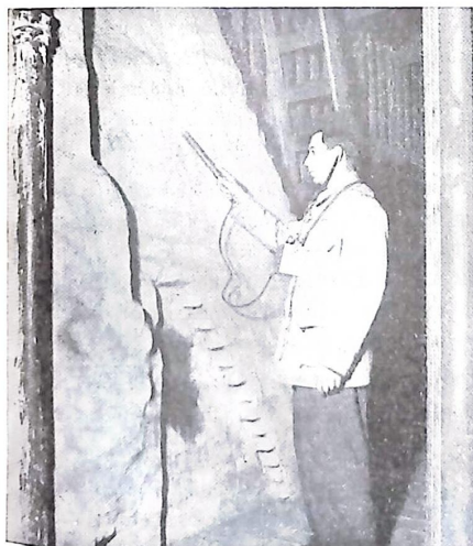
Fig. 2. Mikrofonen, vars ledning omkopplats till sändaren, hänger inne i pipan mitt för skiljetungfelet. Med antenntavlen undersöktes var sändareantennen slutar. Här ligger felet och här skall hålslagning ske.
