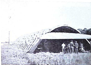
Bild 1. Förvaringsbyggnad uppförd av bräder och papp.
