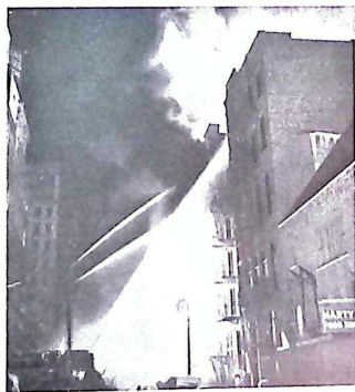
Bild 2. Strålar från vattentorn och kanoner på brandbilar, användas i stor utsträckning mot bränder, som ej äro under kontroll. Byggnadssätt med ringa motståndskraft mot brand tvingar till släckning utifrån.
