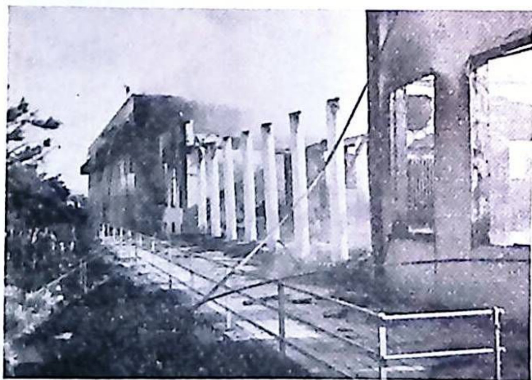
Fig. 2. En del av det brunna Restaurang Tylöhus från sjösidan. I bakgrunden pågår släckningen i Hotell Tylöhus.
