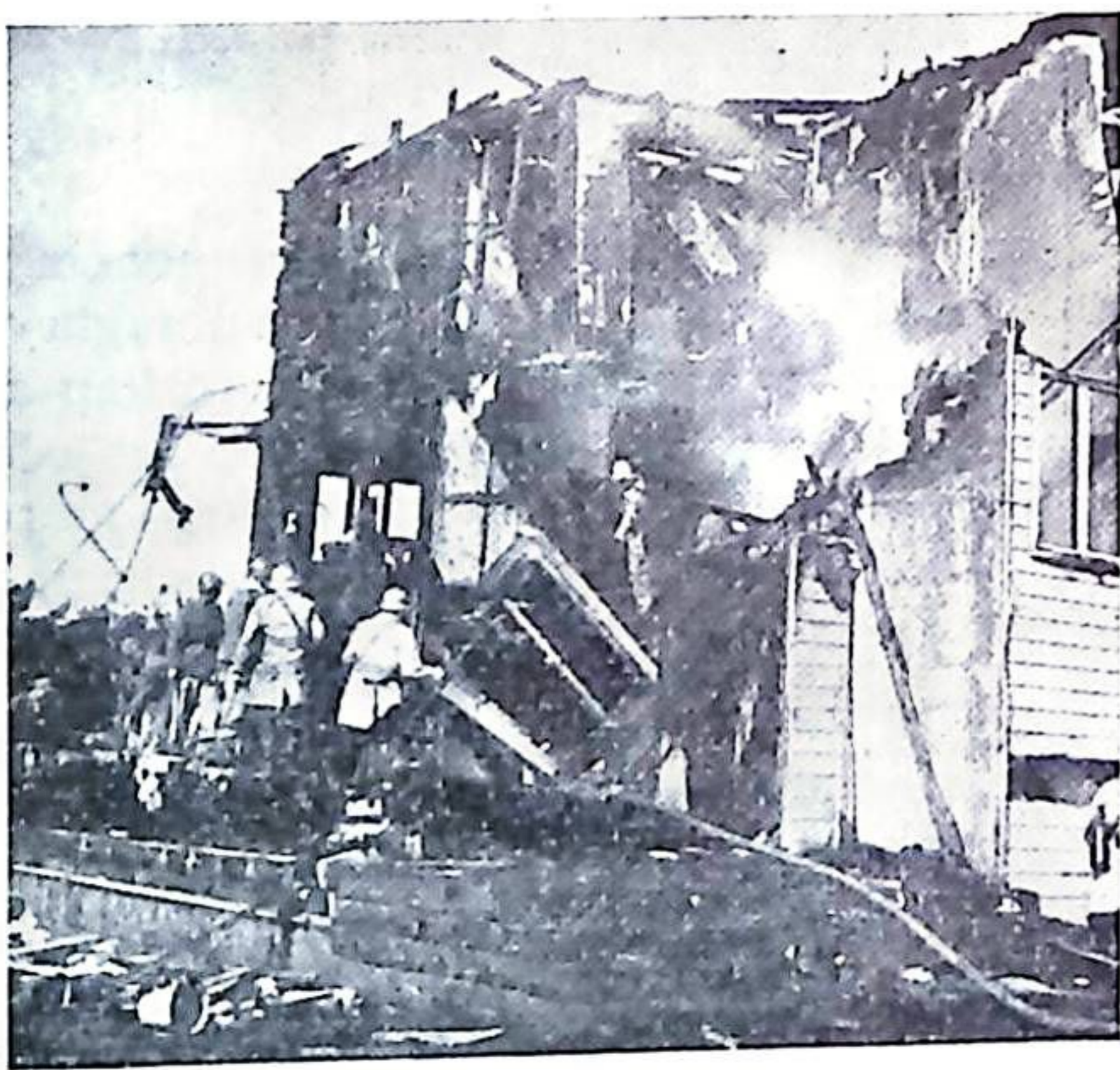
Fig. 4. Branden i Hotell Tylöhus under kontroll.
