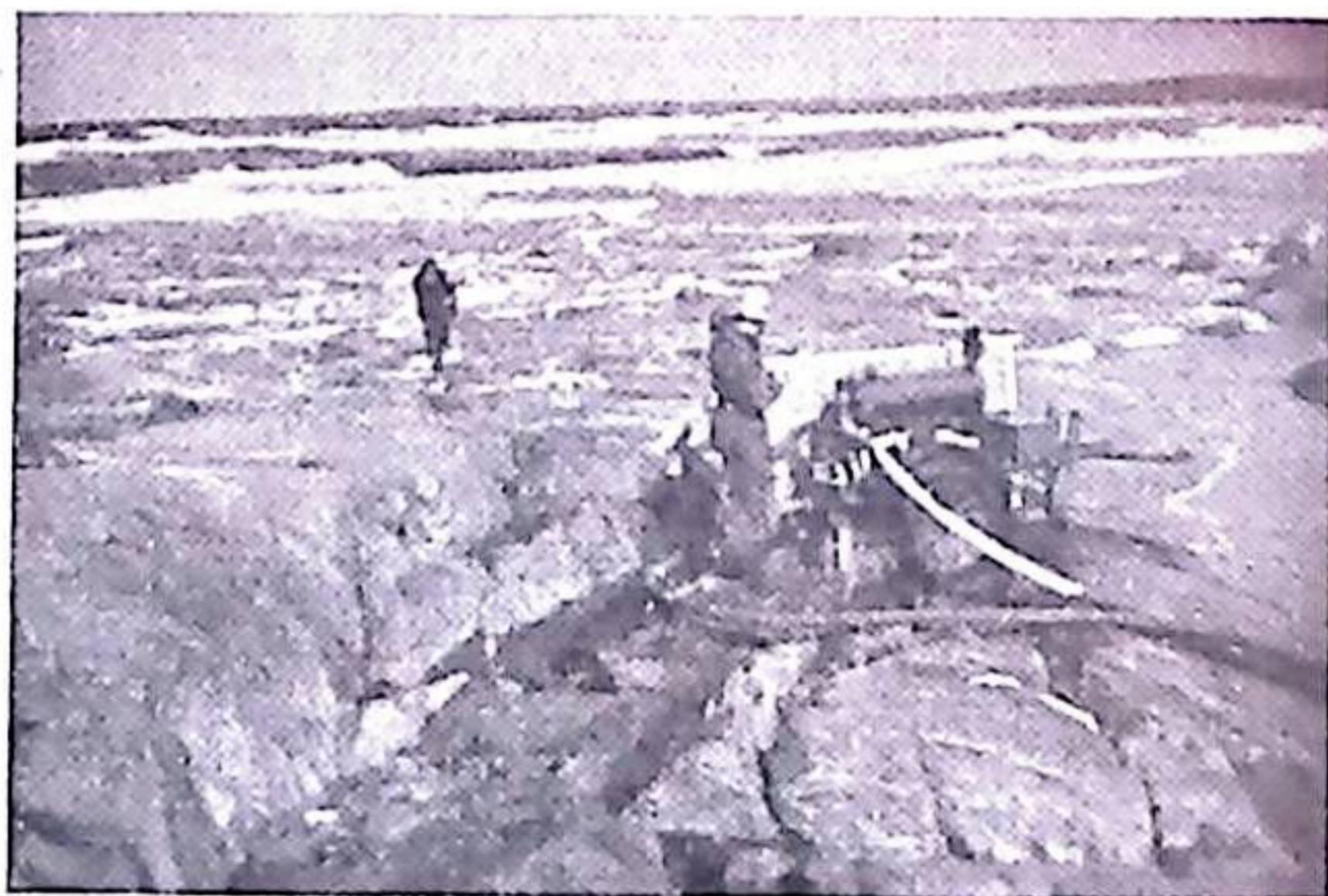
Fig. 3. Trots den starka sjöhävningen vid den långgrunda sandstranden lyckades man hålla sprutan igång. 12 m. sugslang användes.
