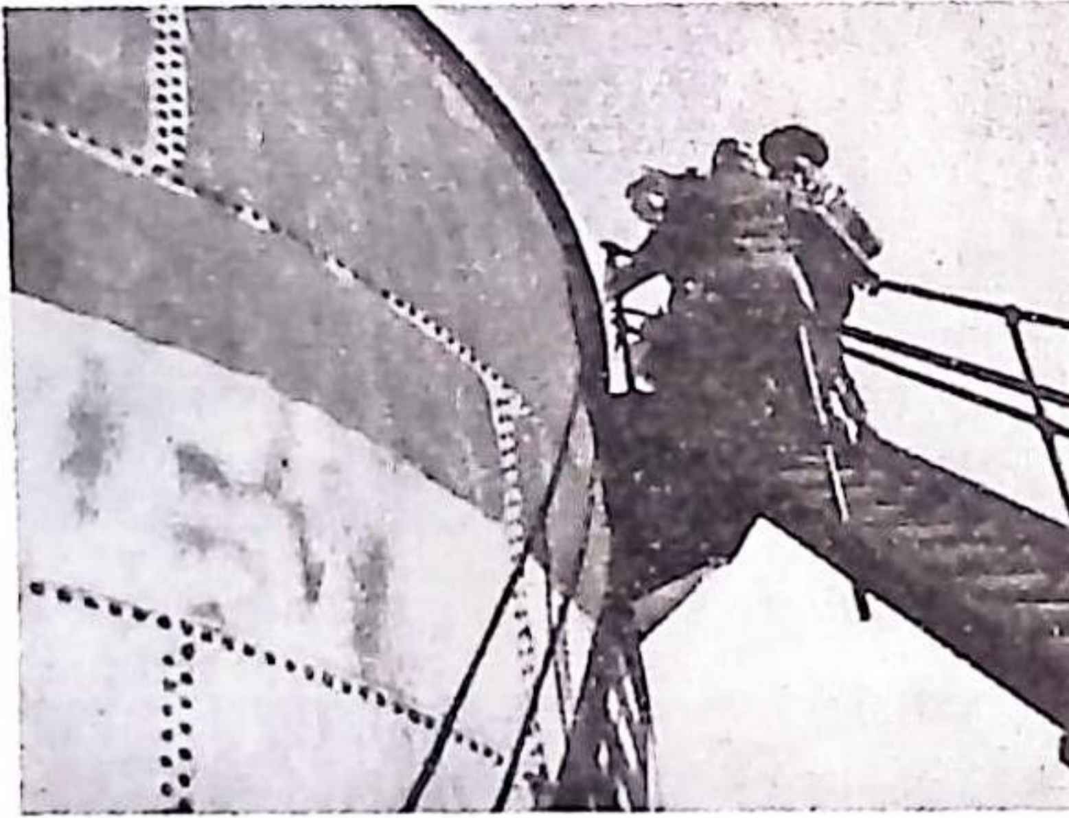
Bild 13. Ytan inspekteras vid crude oil försök. Obs.! Omröringen med luft pågår.
