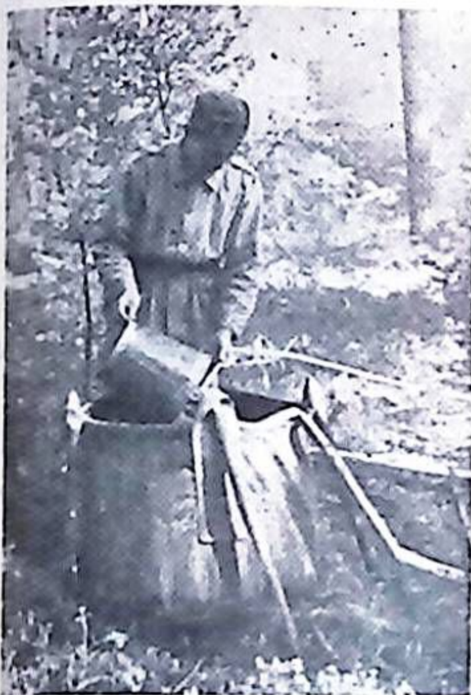
Bild 2. Vattenkar av väv rymmande 300 l. Karet är till formen koniskt och kan stagas med i skogen huggna stöttor.
