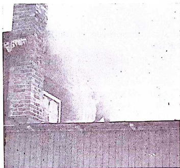
Fig. 2. Angrepp genom fönster. Lågorna försvann omedelbart och ersattes genast av ett till en början rökblandat ångmoln, som på bilden följer fönstret. Vattenmängd i munstycket omkring 100 l/min. För släckningen, som berörde två rum, användes totalt omkring 300 liter.
