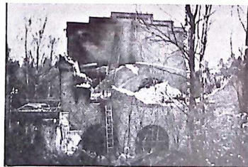
Bild 3. Betongtaket vilande på oklädda takstolar av profiljärn torde ha störtat inom 15 minuter efter brandens utbrott.
