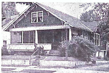
Bild 1. Byggnaden (sedd från norr).
