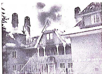
Bild 1. Branden började invid denna skorstensstock.
