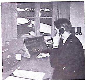
SEKUNDÄRBORD med manöverorgan och omkastare för polisblink.
