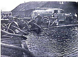
Bild 3. Sprutornas placering vid dammen.
