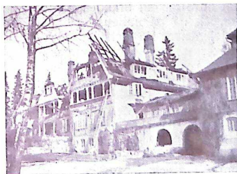
Bild 4. Skadegörelsen sedd från sjösidan.
