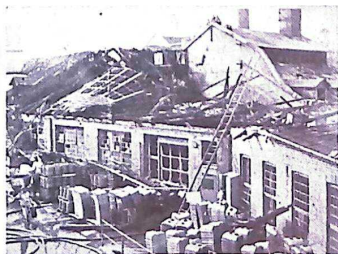
Bild 2. Brandmuren vid Angcentralen. Platsen där elden kunde stoppas är märkt med X.
