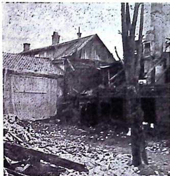
Bild 3. Bilden är tagen sedan avröjning av brandplatsen påbörjats och visar den gavel mot vilken branden stoppades åt Smålandsgatan.
