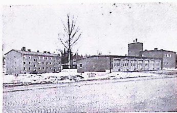
Bild 2. Ludvika brandstation. Länet's yngsta yrkesbrandkår härbergas i denna förnämliga stationsbyggnad som togs i bruk 1954. Till vagnhallen leda sju stora portar, i bottenvåningen finnes televaktrum, expeditionlokal samt lektions- och dagrum för personalen. Å den övre våningen är brandchefens bostad belägen. I brandstationens källare äro förråds- och verkstadslokaler inredda, nämligen två verkstadsrum, rum för slangförråd och oljor, utrustningsförråd, lokaler för civilförsvarets brandmateriel, batterierum, relärum, apparatrum, kompressorrum samt slangtvätt, tvagningsrum och bastu för brandmännen, skyddsrum samt diverse andra källarutrymmen. Till brandstationen hör även ett 18 meter högt övnings- och slangtorn.
