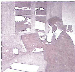
SEKUNDÄRBORD med manöverorgan och omkastare för polisblink.
