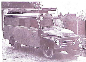
Bild 3. S. k. Kleinfahrzeug byggs på små lastbilschassi eller inredas på standardskåpbilar. De innehåller i allmänhet en bärbar motorspruta på 500 l/min. jämte slang och erforderlig armatur, luget vatten medföres.
