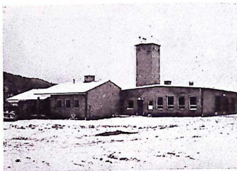
Bild 2. Färila brandstation, färdigställd år 1955.
