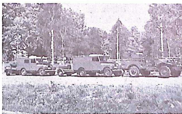
Bild 3. De mindre och terränggående fordonen äro på frammarsch. Ovan det ena av Lönsboda friv. brandkårs två utryckningståg. Från höger tankfordon, slangutläggningsfordon samt personal- och redskapsfordon.
