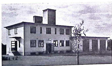
Bild 2. Kombinerad brand- och polisstation i Markaryds köping.
