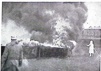
Bild 1. Branden i bergolja kunde icke släckas med vattendimma.
