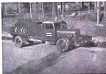
Bild 2. Tankbil vid Ragunda brandkår. Tanken rymmer 2.500 liter. Kostnad: 12.000 kr., varav 6.000 kr. för chassiet.
