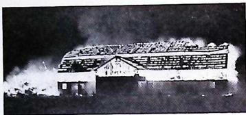
Bild 2. Till vänster på bilden synes rester av logen, som just rasat ihop. I detta skede pågick alljämt livräddningsarbetet.
