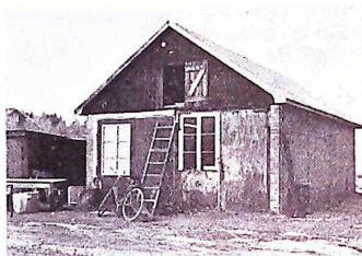
Bild 3. Eksbärads gamla brandstation.
