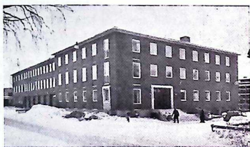
Bild 1. Brand- och polisstationen i Skellefteå stad. Den bortre huskroppen är brandstationen. Vagnhall med 6 st. utryckningsportar. Stationen inrymmer f. ö. 3 befälsbostäder, verkstadslokaler, expeditioner, lek-tionssal och logement med dagrum, samt garageutrymmen i reserv med utkörning mot gården.
