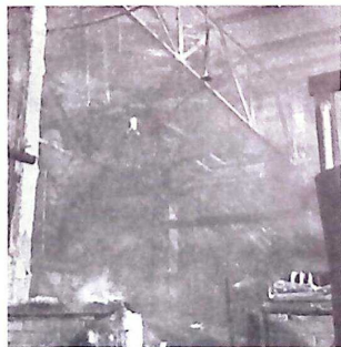
Bild 2. Takets järnkonstruktion klarade sig ganska bra.
