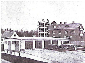
Bild 4. Frövi nya brand- och polisstation.
