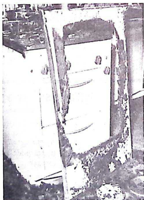
Bild 1. Den brandskadade plattan.
