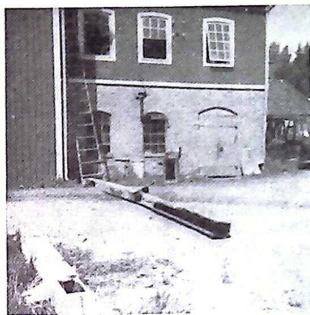
Bild 1. Genom de på fotot synliga sönderslagna fönstren insattes första angreppet mot elden. Till vänster om det å fotot synliga fönstret utmynnade den ventilationstrumma varur lågor slog ut vid brandkårens framkomst.
