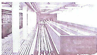
Bild 7. Provtryckning av 4 slangar samtidigt i en ränna med lutning 1:50.
